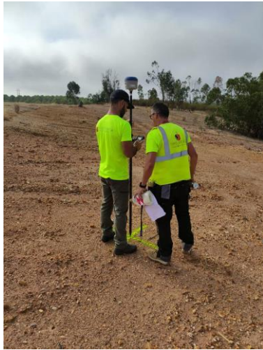
Trabajos de topografía. (Fuente: Proyecto RIBERMINE)
