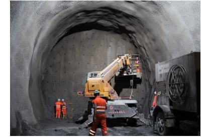
Construcción de túnel (Fuente: Pixabay)
