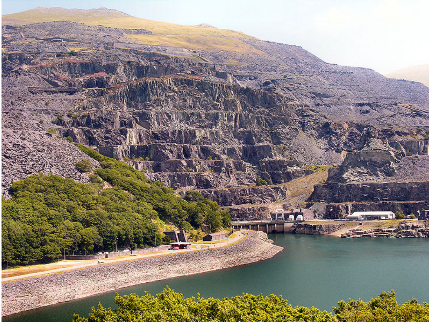
Central Hidroeléctrica de Dinorwig. Gales
